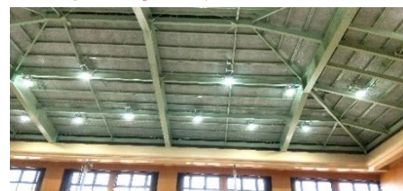
天井が新しく、明るくなりました
